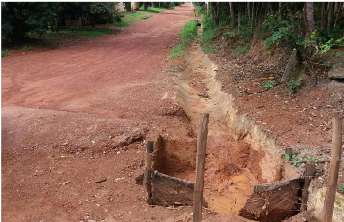
Figura 20 - Sedimentos a retirar na caixa coletora após 48 horas de finalizar a chuva.
