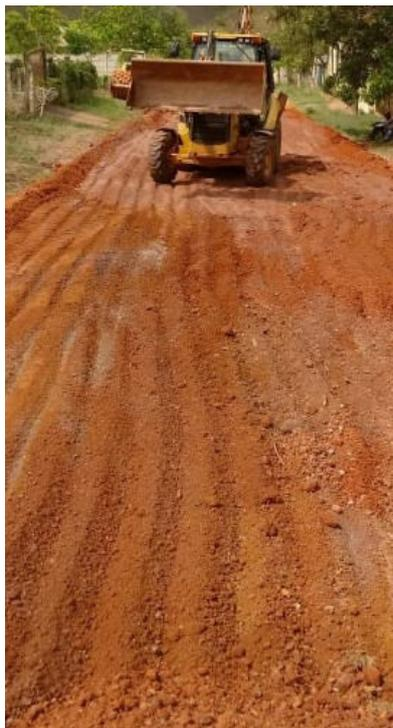
Figura 9 – Equipamento homogeneizando a camada.
