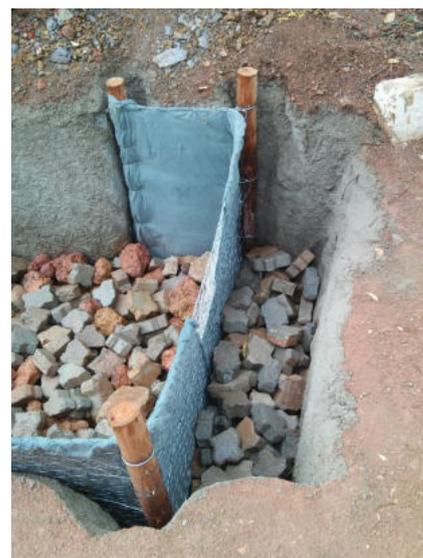
Figura 16 – Dupla barreira de retenção de sedimentos na caixa coletora com dupla barreira do trecho 2.
