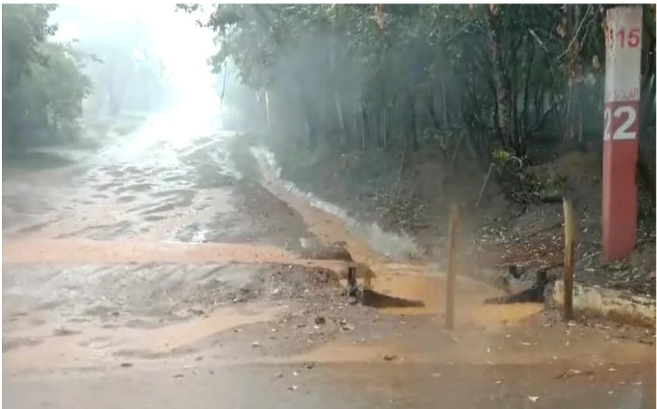
Figura 18 – Conjunto de soluções de drenagem funcionando durante a chuva no trecho 2.
