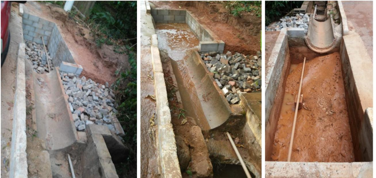
Caixa com dissipador de energia no fundo
