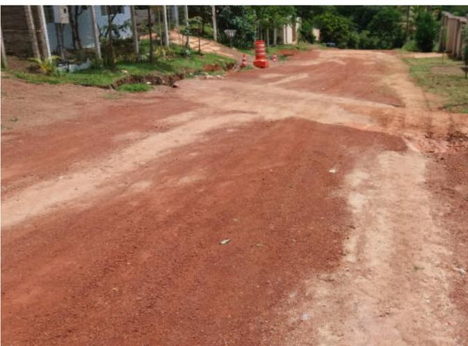
Figura 28 – Exemplos de solução de danos nas vias com solo-cimento compactado.
