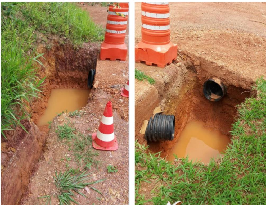
Figura 24 – Caixas coletoras e tubos de travessias cobertos com solo-cimento.
