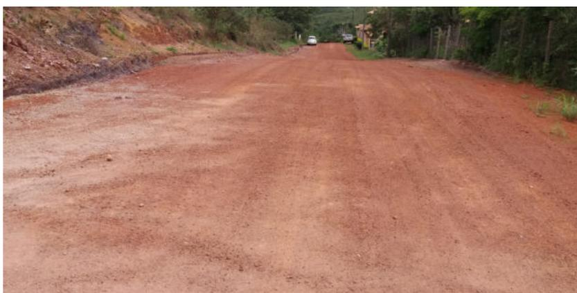
Via regularizada com cascalho compactado e com soluções de drenagem
