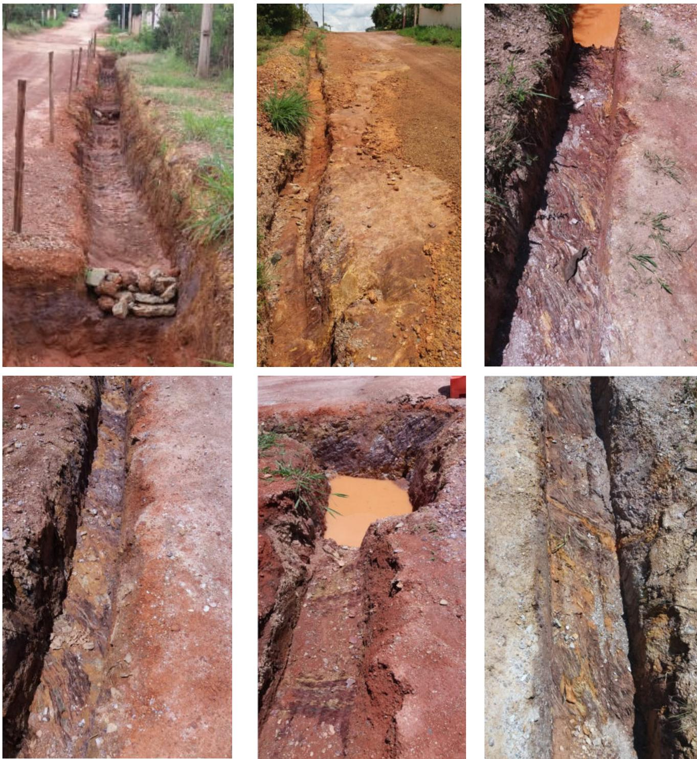
Figura 21 – Valetas escavadas na rocha por métodos manuais e mecanizados.
