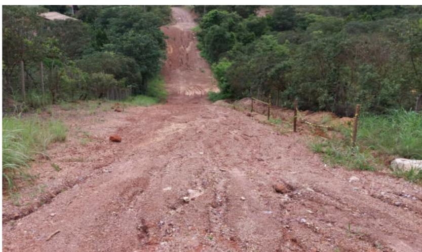
Via regularizada com cascalho sem compactar e sem soluções de drenagem
