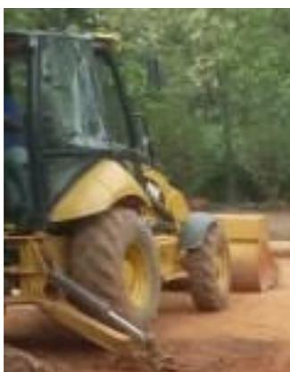
Figura 9 – Equipamento empregado para a colocação e homogeneização da camada.
